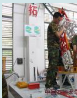
钻井设备安装训练—井架安装
